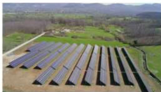
Impianto fotovoltaico sviluppato da Seapower a Buonabitacolo (Campania)
